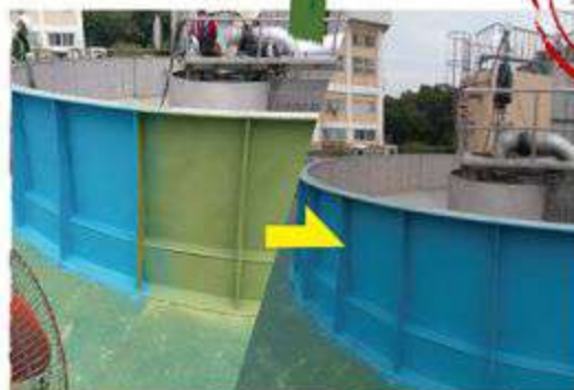
ST槽體塗裝前 → ST槽體塗裝後
